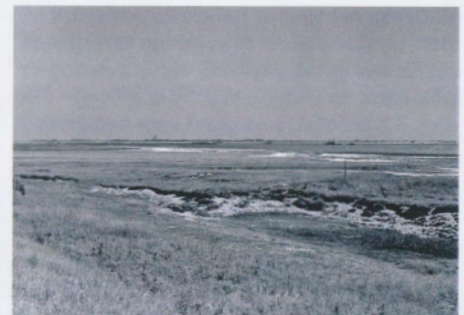
Aanleg Brielse Dam door het Brielsche Gat in 1949. Foto: F.P.J. Kooijmans
