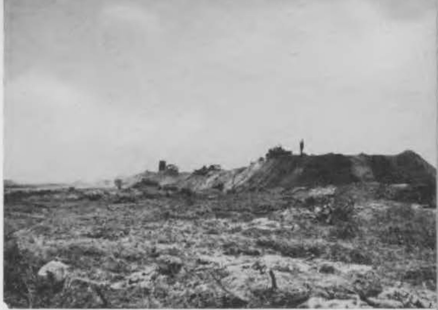
Op een terrein, dat vorig jaar nog begraaid was met duindoorn, zijn nu de werkzaamheden voor de bouw van de Euro-poort in volle gang. foto: F. van Ommen
