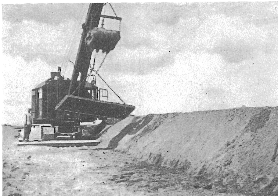
fig. 5. Opwerken van het zandlichaam van den zuidelijken dijk.
