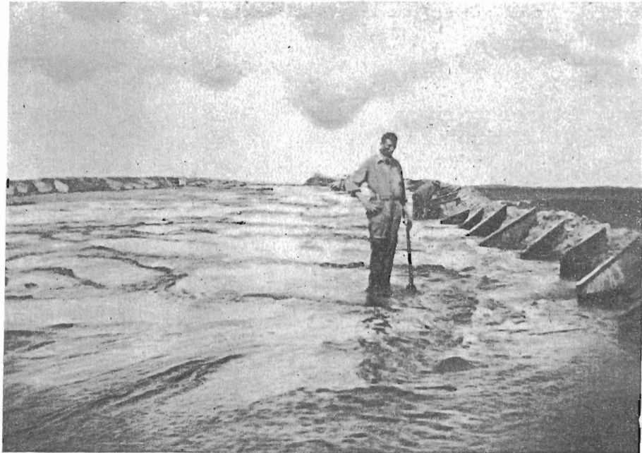
fig. 4. Stort van in aanleg zijnden zuidelijken dijk
